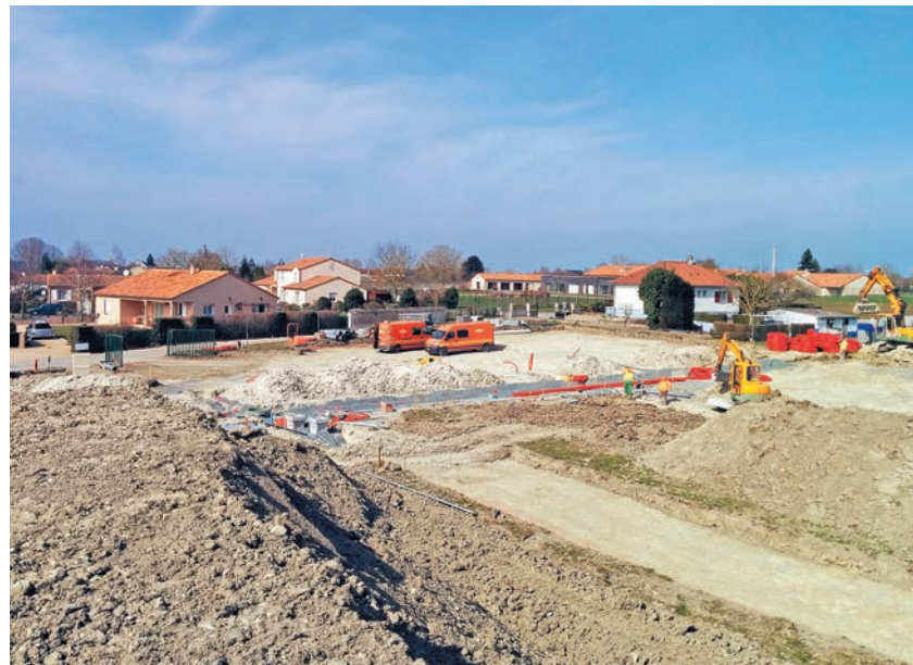
Les travaux du futur Village d'Enfants de Monts-sur-Guesnes progressent : ils entrent dans la phase de terrassement et de fondations. L'ouverture du Village est prévue pour l'été 2016.
